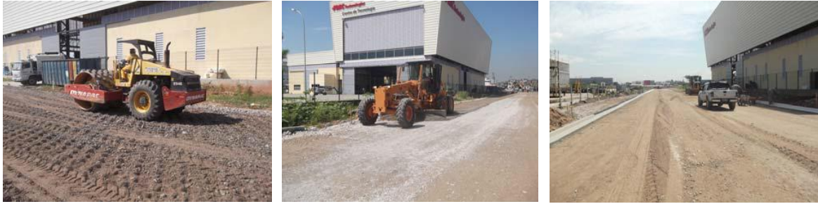
Figura 11: Execução de base realizada com RCD.
