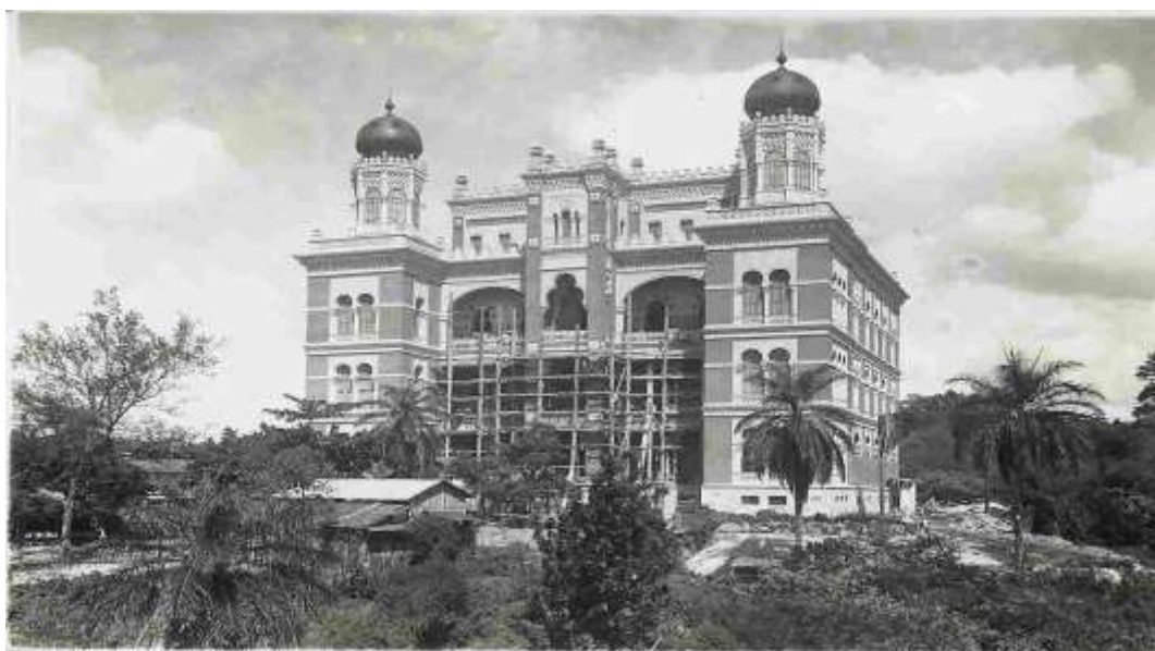
Figura 2 – Castelo - Edifício em construção, em 1910
