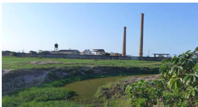
Imagem 9 – Trecho do Canal Campos Macaé e ruínas da Usina Engenho Central (Quissamã).
