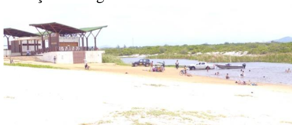
Imagem 16 – Infraestrutura de apoio à visitação na Lagoa de Jurubatiba
