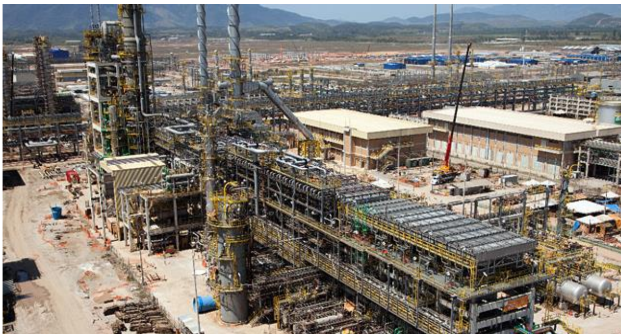
Figura 1.2 – Obras do Trem 1 de Refino do Comperj Fonte: Petrobras, 2017
