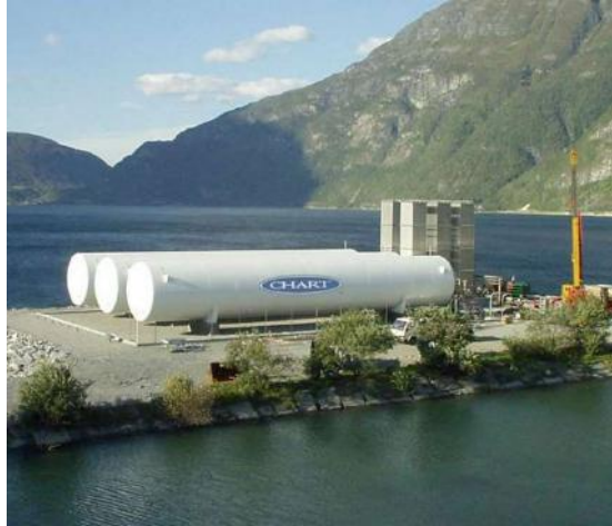
Figura 16 - Tanques pressurizados bullet
