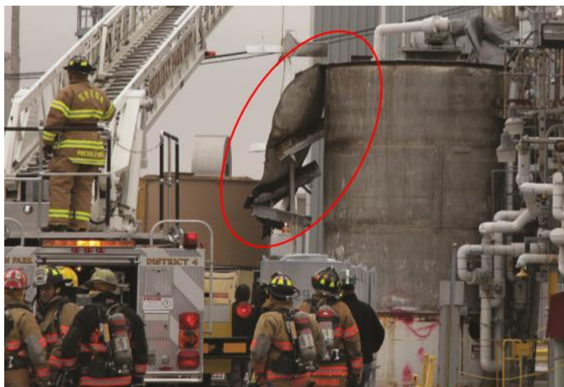
Figura 4 – Imagem pós-acidente envolvendo explosão do tanque com gases inflamáveis. Modificado de CSB, 2012.
