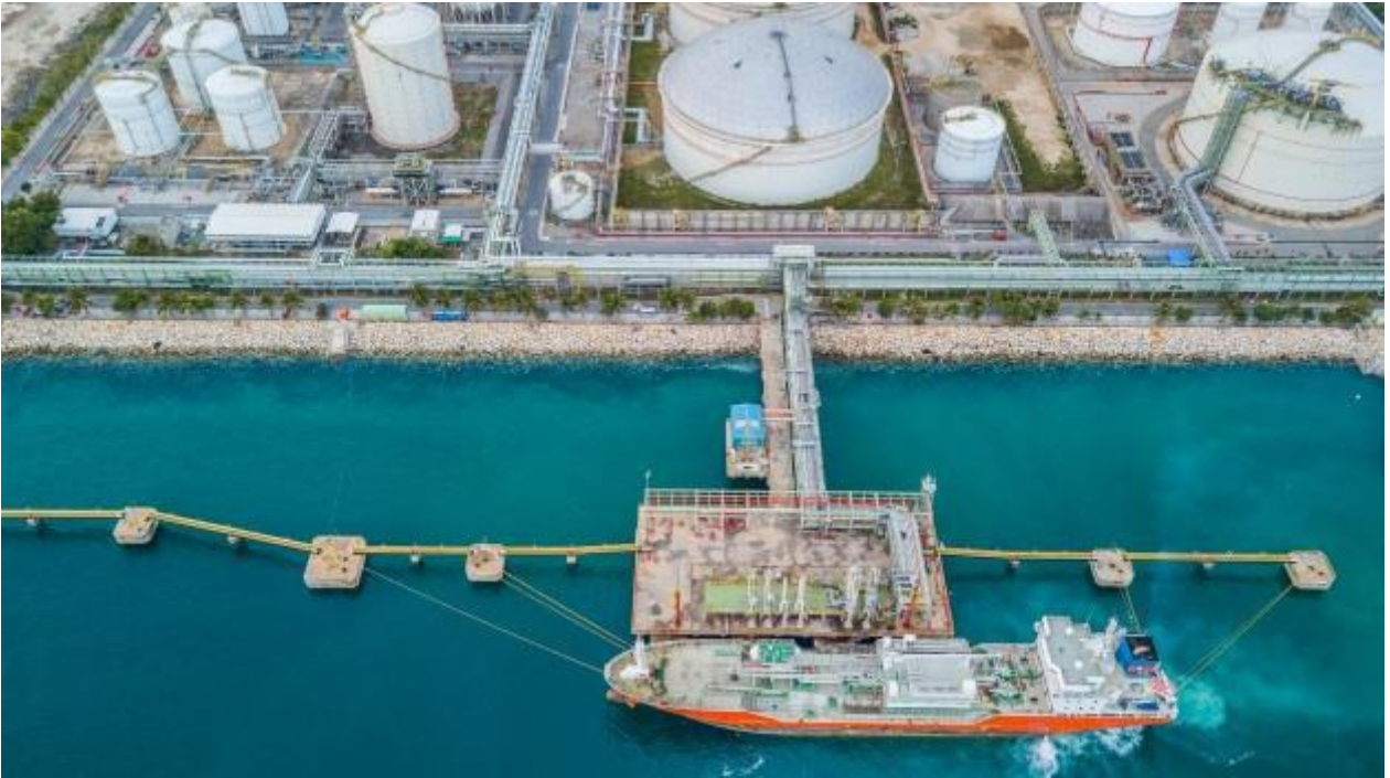
Figura 7. Terminal aquaviário para recebimento de petróleo cru
