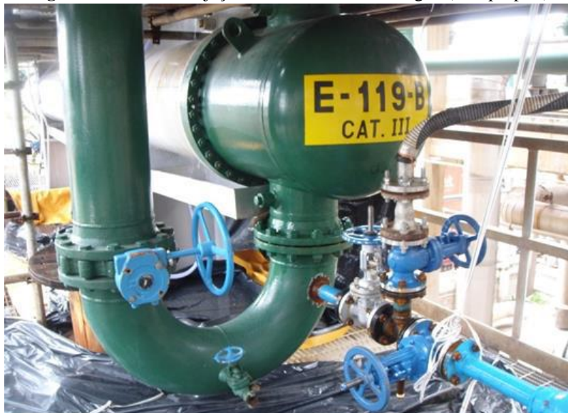
Figura 23. Ponto de injeção de ácido na linha de água (foto própria)
