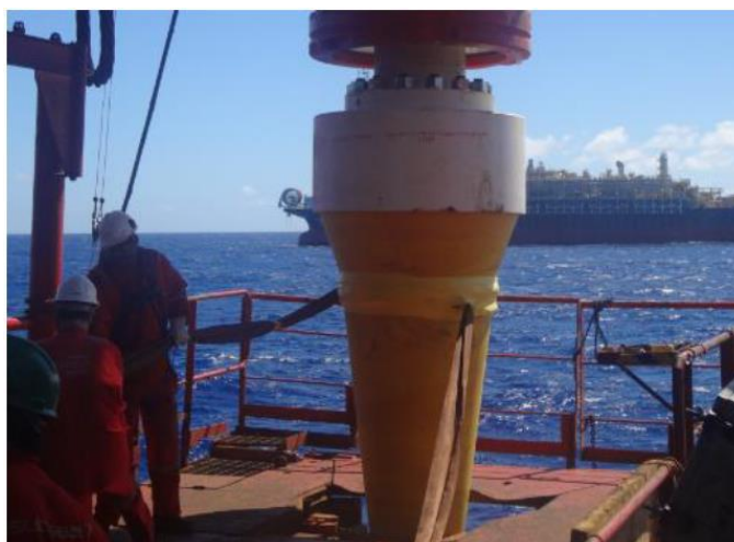
Figura 8 – Instalação de enrijecedor à flexão [10]
