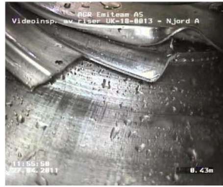
(b) Rompimento abaixo da terminação.
