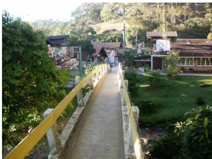
Figura 4.5: Ponte sobre o Rio Preto que separa o município de Itatiaia no Rio de Janeiro e o município de Bocaina de Minas em Minas Gerais. (fonte: tripadvisor.com.br)
