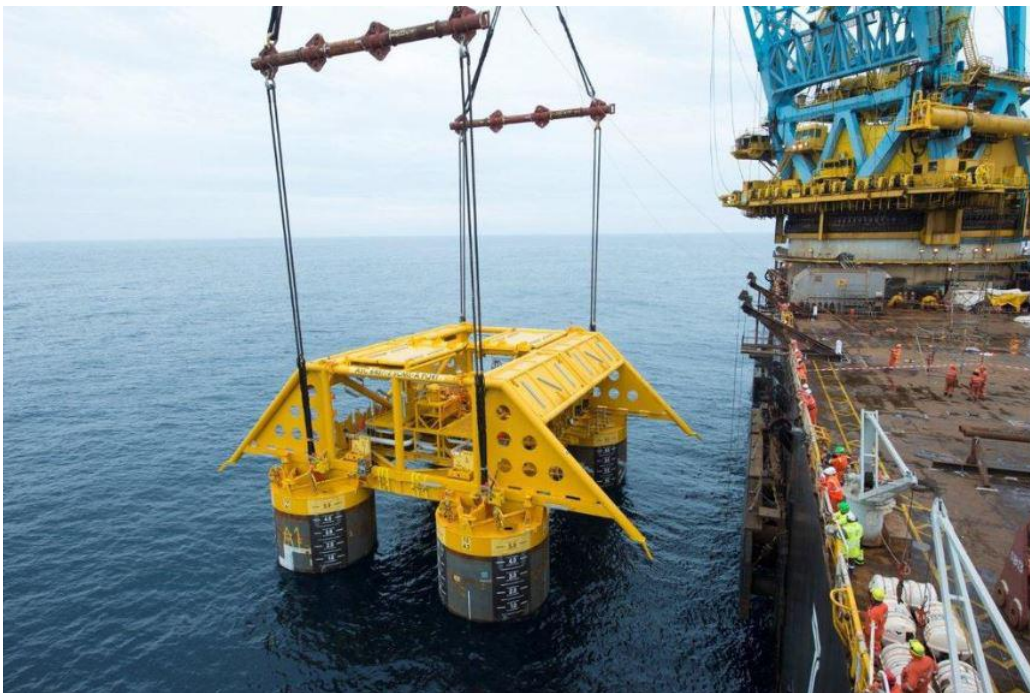
Figura 2.6: Exemplo de template submarino (fonte: oilandgastechnologies.wordpress.com ).
