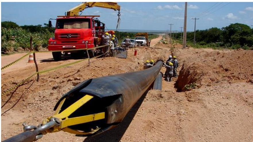
Figura 19: Instalação de liner [1]
