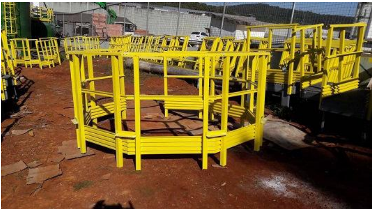
Figura 30 - Instalação de guarda corpos e plataformas de trabalho em empresa de Criciúma/SC. Fonte: < http://www.iso-compositos.com.br/mobile/noticias.asp?idnoticia=24&lang=> >
