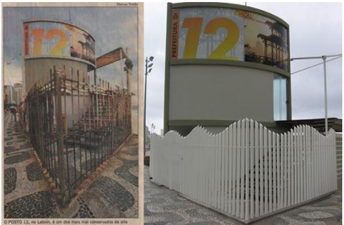
Figura 37 - Posto de salvamento da orla do Rio de Janeiro. À esquerda, gradis de ferro corroídos pelos efeitos de intempéries, enquanto à direita, temos gradis em fibra de vidro substituídos pelos de ferro. Fonte: < http://cogumelo.com.br >
