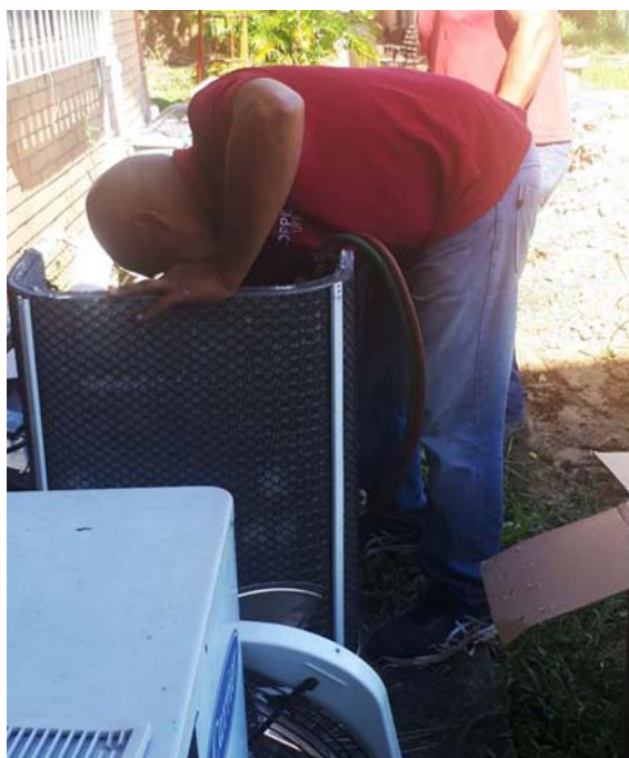
Foto 10 – Técnico do Centro de Manutenção da Coppe/UFRJ realizando uma troca de compressor de um ar condicionado tipo split
