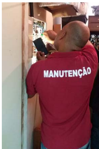
Foto 6 - Técnico iluminando o quadro de força com a lanterna do telefone celular
