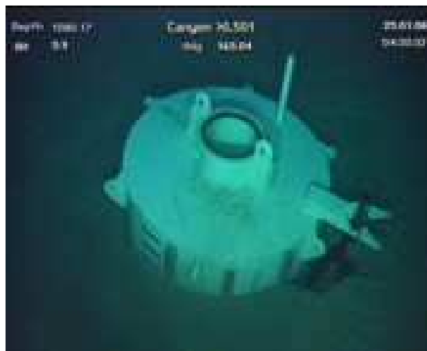
Figura 12 - Estaca de sucção instalada(SPT, 2007)
