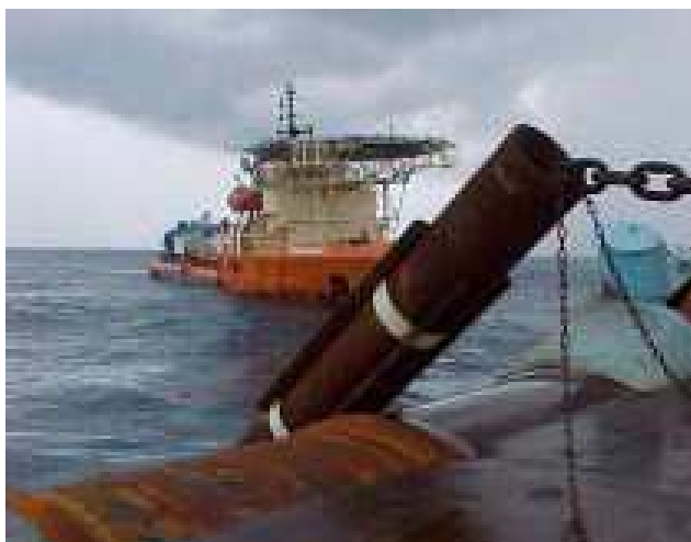
Figura 18 - Instalação de estaca torpedo para ancoragem de risers (MEDEIROS, 2002)
