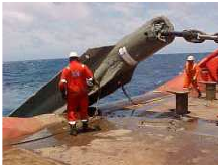
Figura 20 - Estaca Torpedo para ancoragem de MODUs(Medeiros, 2002)
