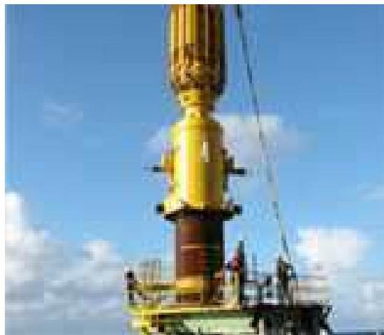
Figura 10 – Martelo Hidráulico (Menk, 2008)
