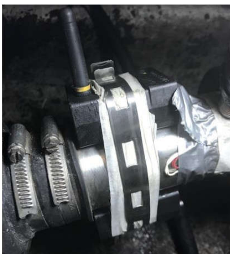
Figura 5.3. Instalação de strain gage e sistema de telemetria.
