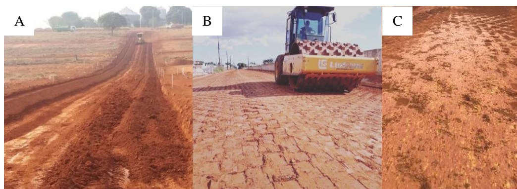
A – Homogeneização e espalhamento do material; B – Compactação; C – Base acabada. Figura 32 – Exemplo de execução de base com laterita na cidade de Sorriso
