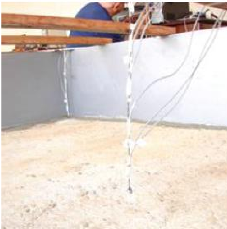
Figura 6.2: Termômetros instalados no centro da forma (LYNX - COPPE)
