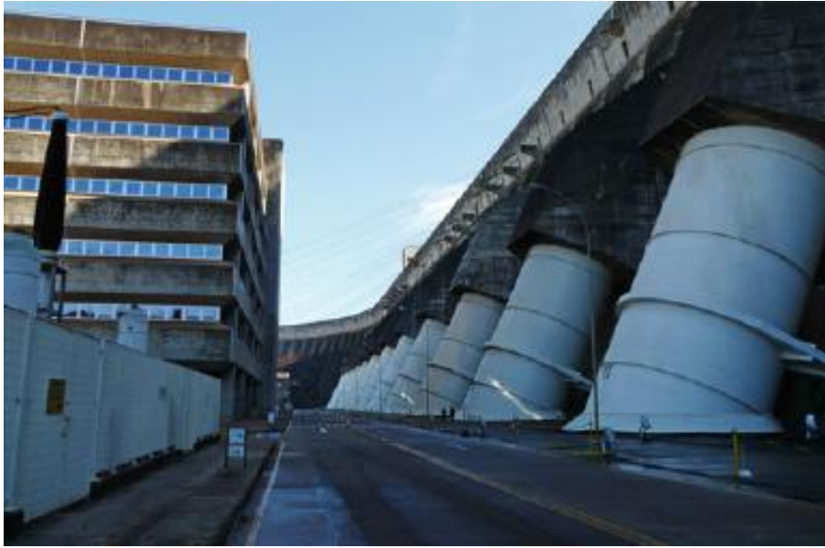
Figura 1.3: Usina Hidrelétrica de Itaipu. (Fotografias de E. M. R. Fairbairn) - Vista da entrada.
