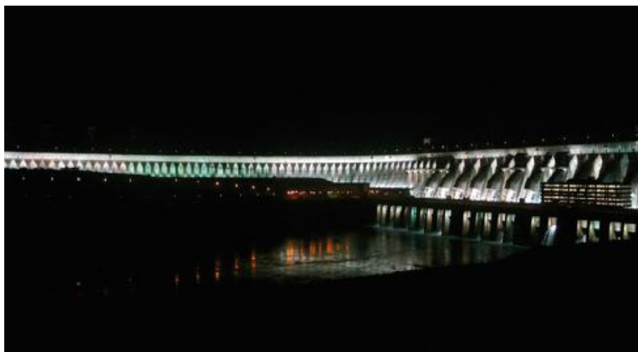
Figura 1.2: Usina Hidrelétrica de Itaipu. (Fotografias de E. M. R. Fairbairn) - Vista geral da barragem de concreto.
