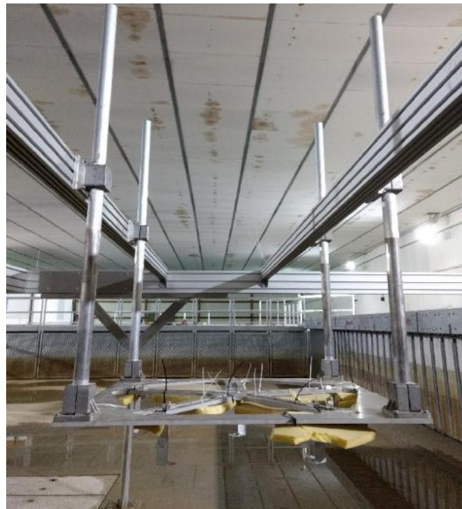
Figura 7.5. Plataforma metálica destinada à colocação do arranjo 1 de USSs.
