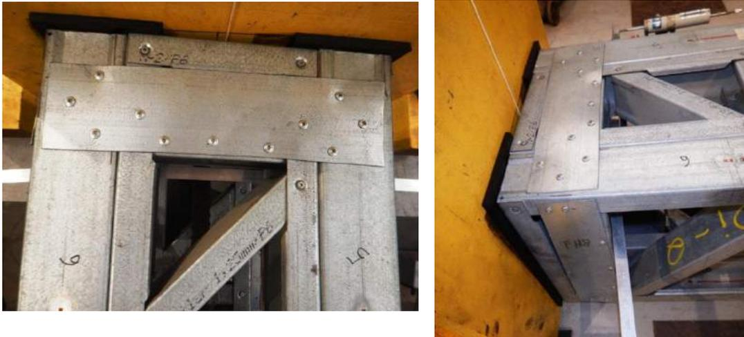
Figura A5.33 Reforços com chapas aparafusadas instalados nas cabeças da treliça.
