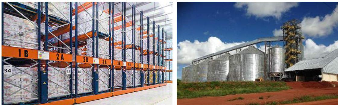
Figura 1.1 (a) Exemplo de aplicação de PFF em racks (fonte: acervo Mecalux). (b) Exemplo de aplicação de PFF em silos para armazenagem de grãos instalados em Capinópolis, MG (fonte: acervo Armco Staco S.A.).
