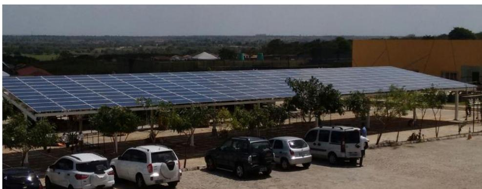
Figura 76- Exemplo de usina montado no teto de estacionamento
