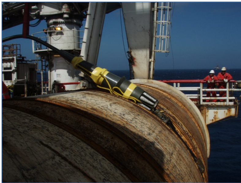
Figura 3.5-4 - Extremidade saindo do PLSV com calha rotativa
