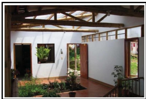
Figura 2.17- Edificações construídas com painéis de bambu revestidos com argamassa. Fonte: ACFA (2005); Teixeira (2006)
