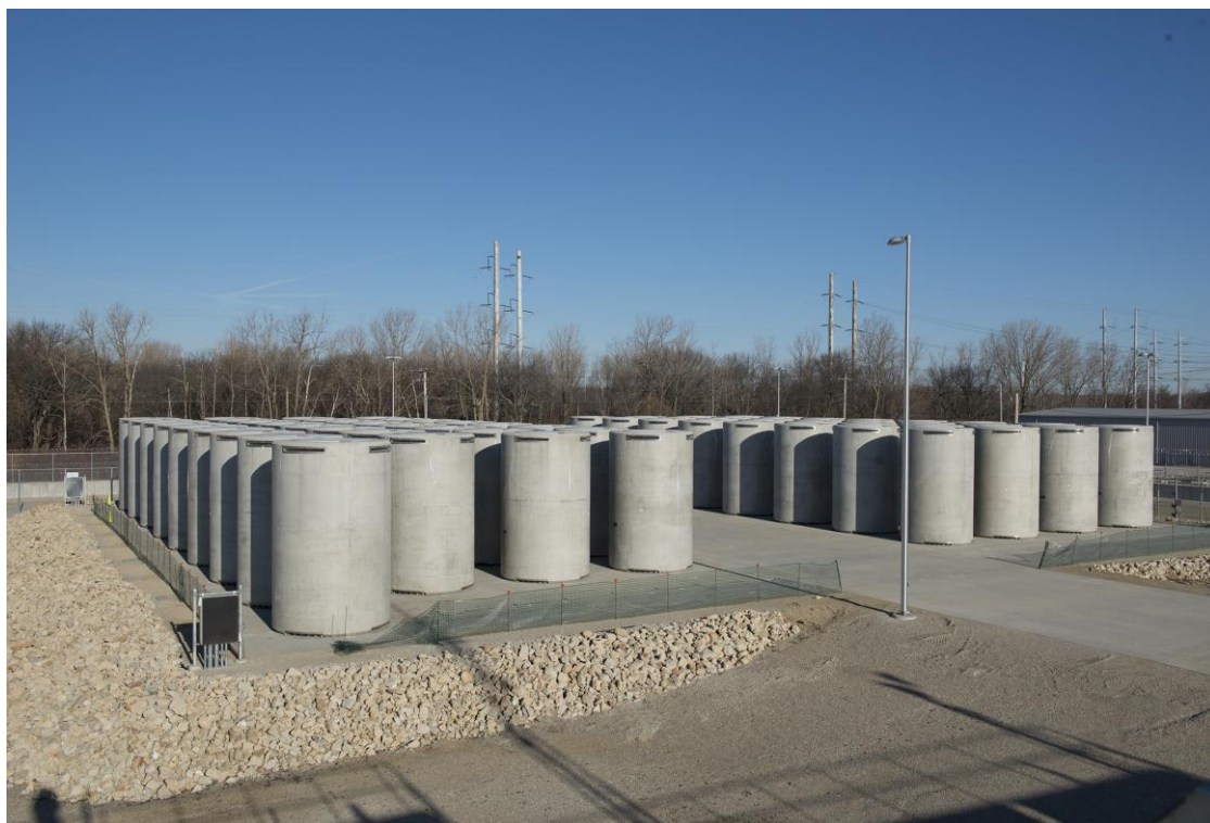
Figura 5 - Dry-casks para armazenamento de combustível irradiado (ZionSolutions, 2015)
