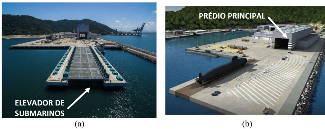
Figura 19: Prédio principal e elevador de submarinos do estaleiro de construção do SN-BR em Itaguaí-RJ. (a) entrega do elevador de submarinos em dezembro de 2017. (b) concepção artística do local. Fonte: PODER NAVAL [28, 29]
