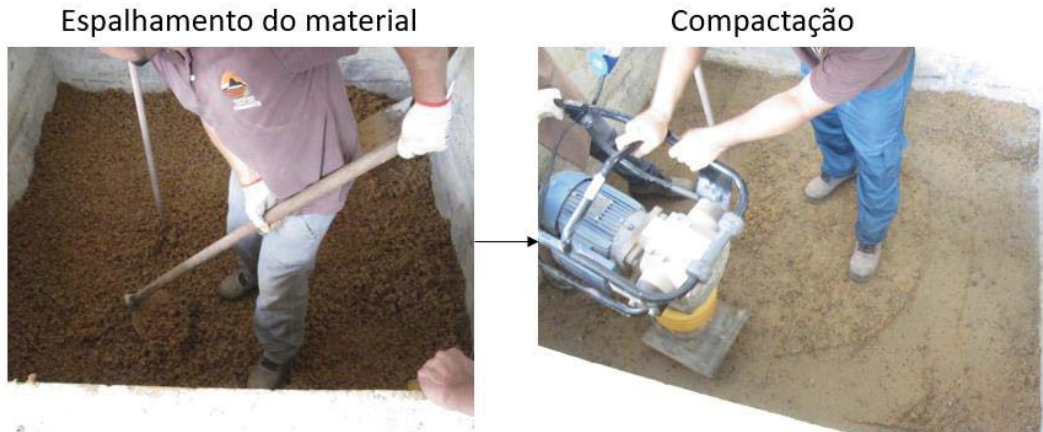
Figura 3.20 – Execução da camada de sublastro no tanque teste nesta pesquisa
