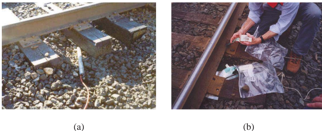
Figura 2.34 – Aquisição de tensões no pavimento ferroviário: (a) Célula de pressão total entre o dormente e o lastro; (b) Sensor Tekscan entre trilho e placa de apoio Fonte: Anderson e Rose (2008)
