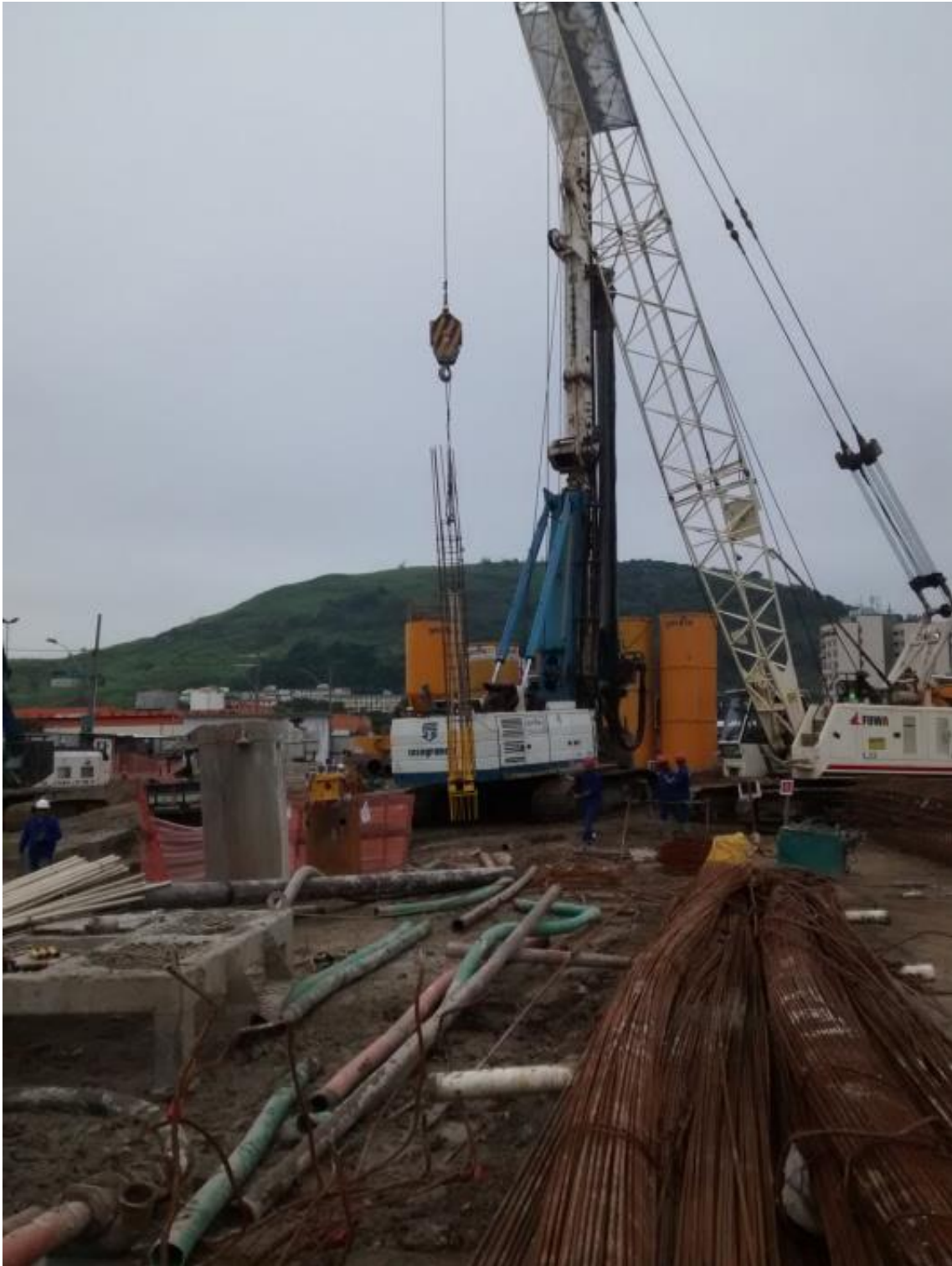
Figura 40: Içamento da armadura com o conjunto de células expansivas da P-22B.
