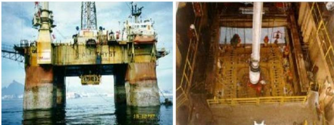
Figura 3.14 – Instalação de manifold utilizando riser de perfuração [27]
