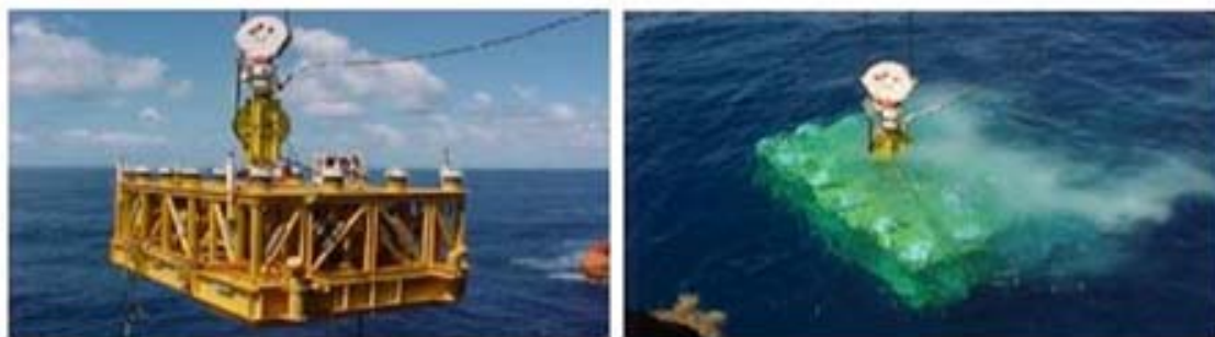
Figura 3.10 – Manifold sendo instalado pelo método da roldana [27]
