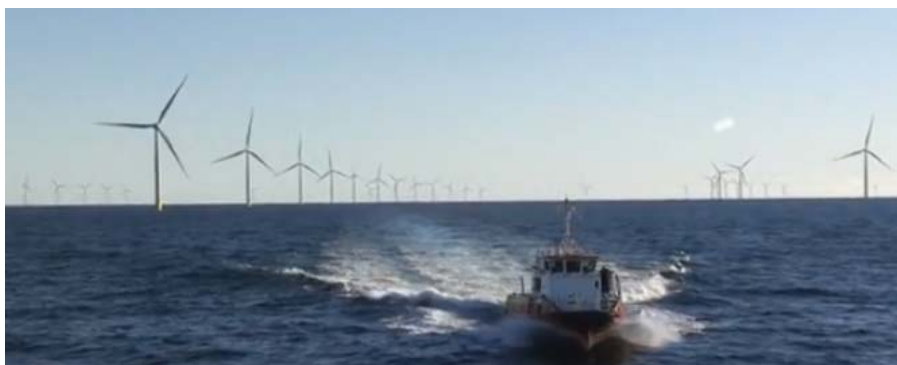
Figura 3 – Fazenda eólica offshore de Anholt, Dinamarca [8].
