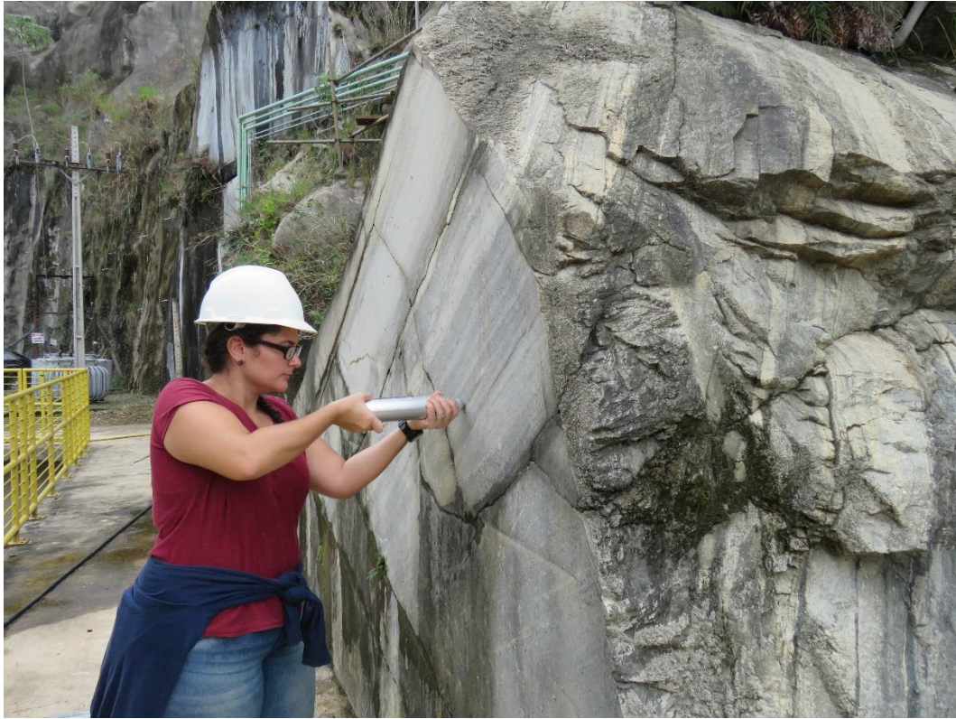
Figura 2.12 - Realização de ensaio com Martelo ou Esclerômetro Schmidt.
