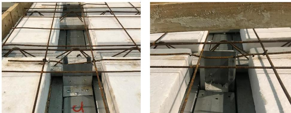
Figura 4.69 – Detalhes do conector TWVP: (a) vista anterior e (b) vista posterior
