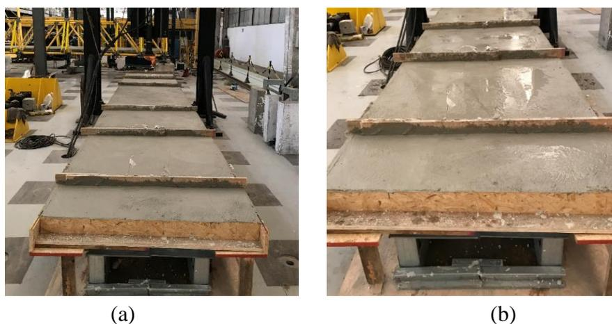
Figura 4.12 – Aspecto da laje imediatamente após a etapa de concretagem do protótipo TWP
