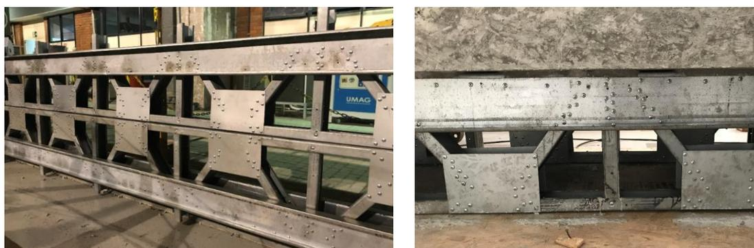
Figura 4.70 – Detalhe das ligações entre o conector TWVP e a treliça metálica (faces laterais): (a) durante a etapa de montagem das treliças e (b) após a concretagem do protótipo
