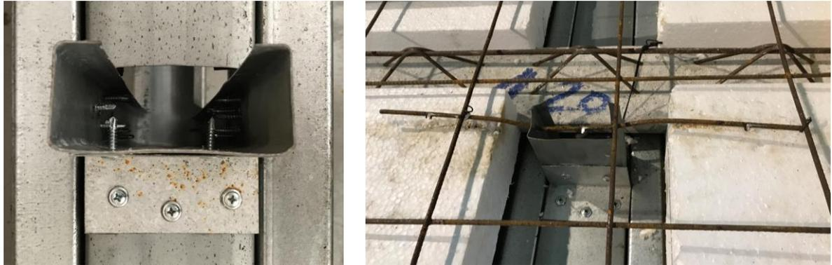
Figura 3.28 – Detalhes relacionados ao recorte no banzo superior e à presença de armadura transversal “atravessando” o conector TWVP
