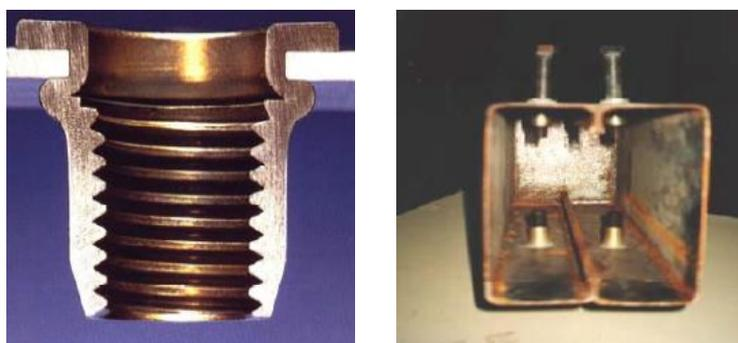
Figura 2.23 – Conector tipo pino com cabeça rosqueado sobre a mesa superior (FONTE: OLIVEIRA, 2001)
