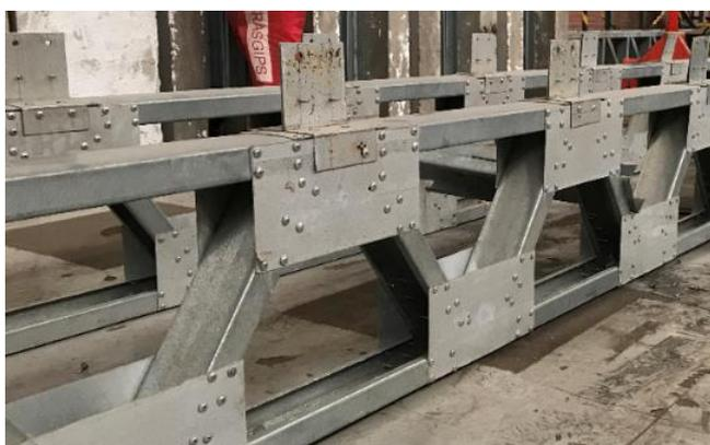
Figura 4.8 – Detalhe do conector TWP e dos reforços na região dos nós da treliça metálica
