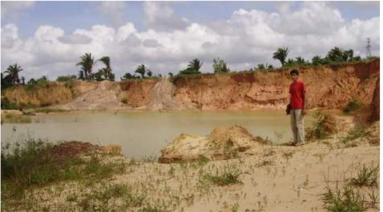
Figura A1.34 - Acúmulo de água em face a escavação da jazida.
