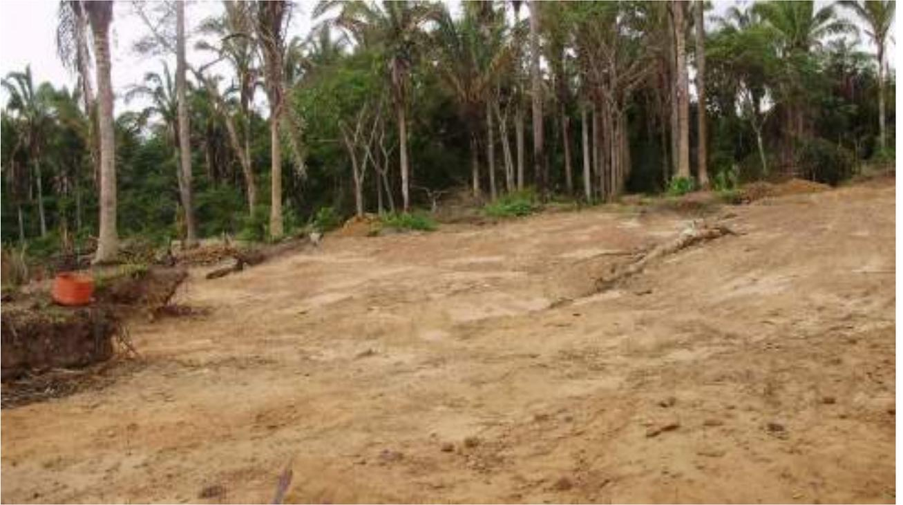
Figura A1.51 - Retirada da vegetação e do primeiro horizonte do solo.
