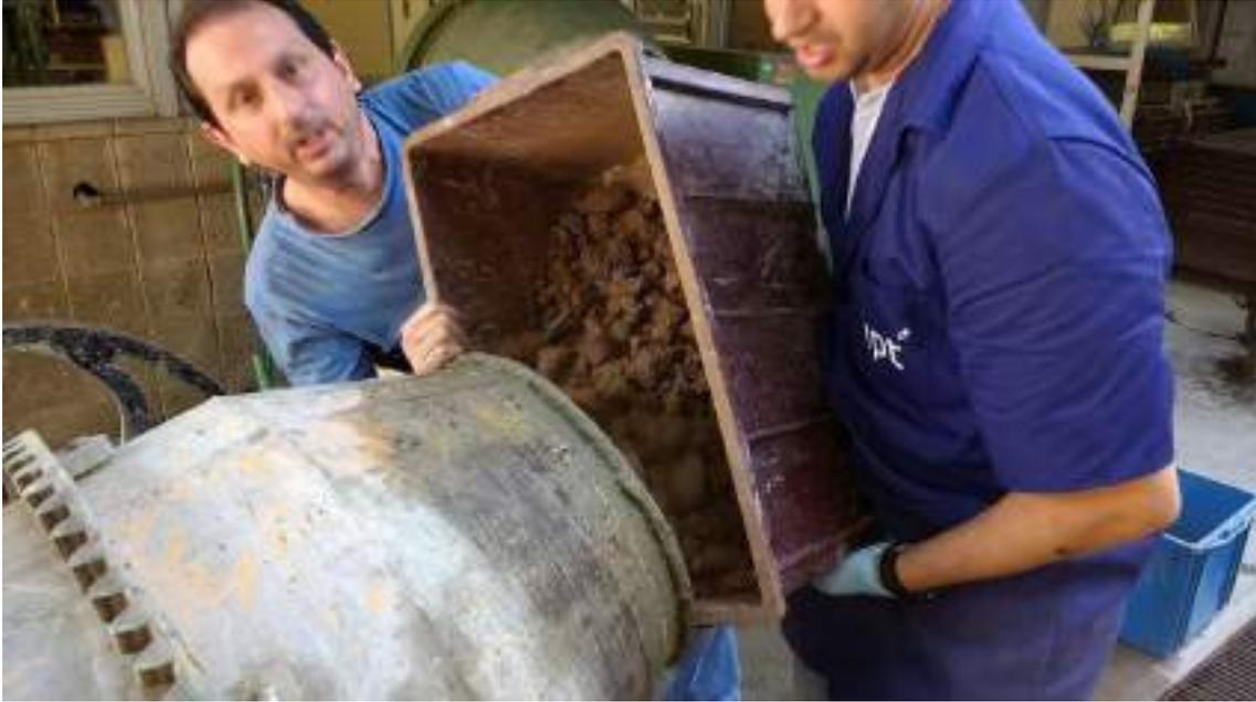
A2.8 - O material citado na foto anterior é lançado na betoneira para primeira homogeneização a seco, após recebe agua na proporção prevista para término da homogeneização.
