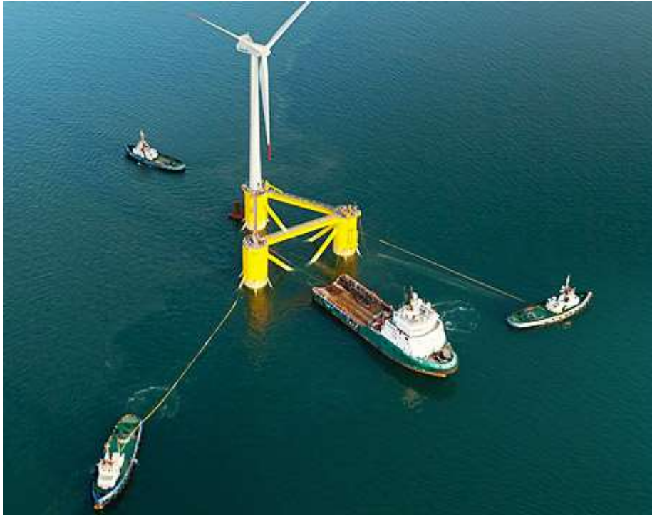
Figura 1-9: Unidade Flutuante Semissubmersível, projeto Windfloat . Fonte: Principle Power (2018).
