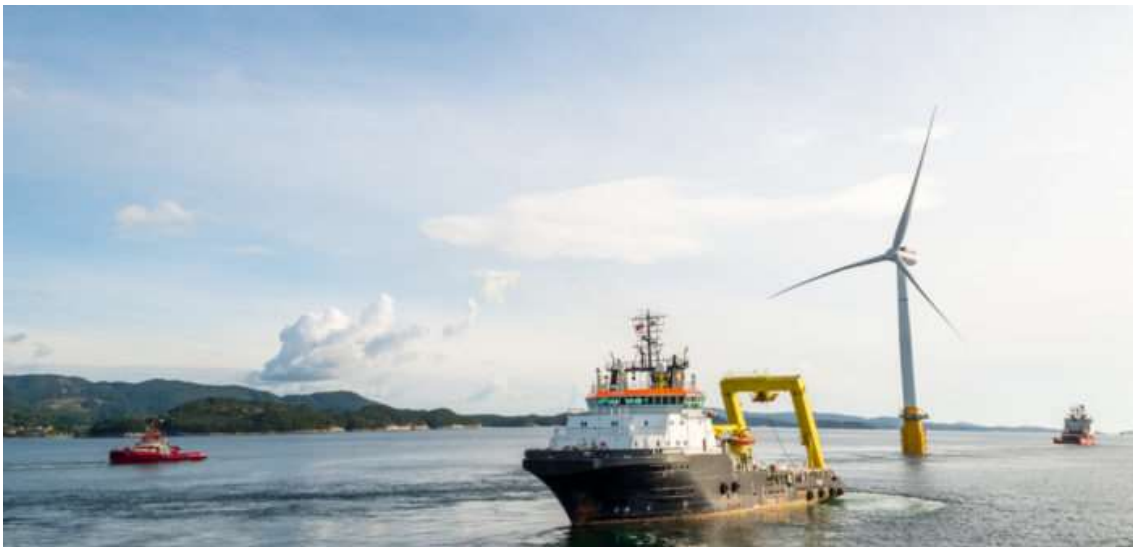
Figura 1-8: Unidade Flutuante tipo Spar , projeto Hywind . Fonte: Equinor (2018).
