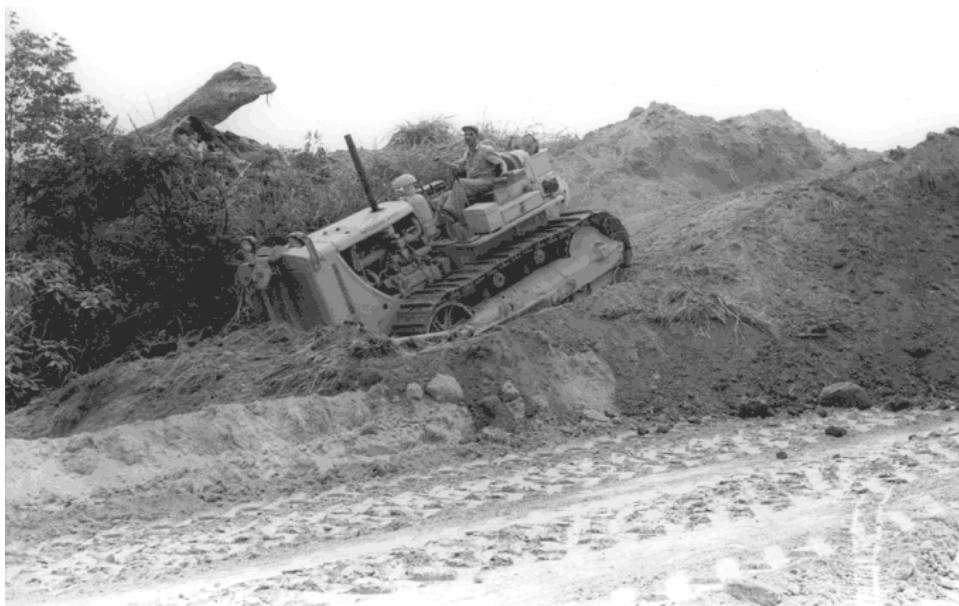
Parte do aterramento foi viabilizado com o desmonte do morro do Fundão (Acervo ETU/UFRJ)
