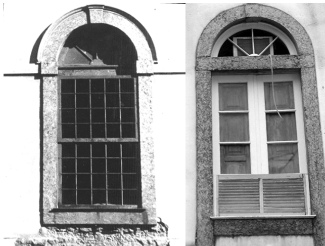
Fig. 6: Janela com grade e depois da remoção. Fonte: IPHAN, 1948 e foto da autora, 2006.
