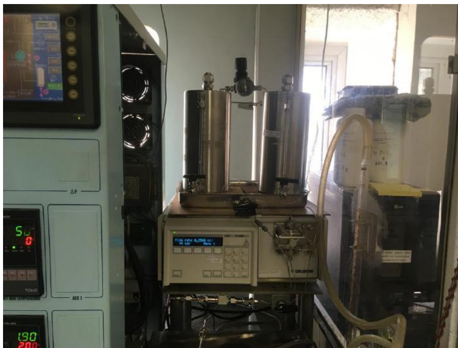
Figura 4.2: Tanques de carga de sulfetação à esquerda e de reação à direita e bomba de deslocamento positivo sob os tanques.
