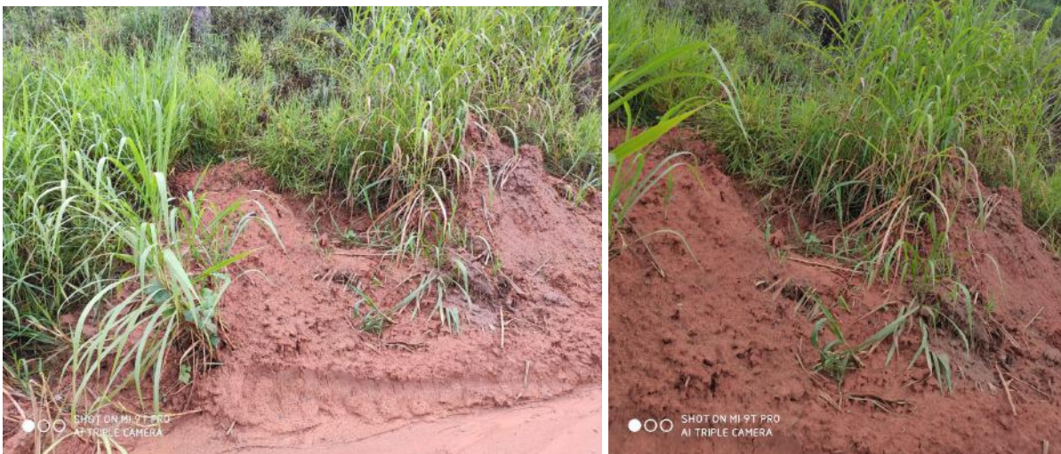
Figura 4: Material residual do interior da voçoroca
