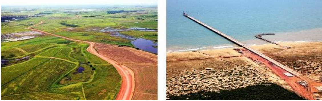
Figura 3.7 – (a) Trecho do mineroduto e (b) seu terminal em Porto de Açu, Rio de Janeiro. Ambas as imagens são do mineroduto da Anglo Ferrous Brazil. [30]
