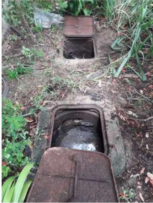
Figura 11: Fotos das caixas de inspeção e retentora de gordura existentes. Fonte: Autores.
