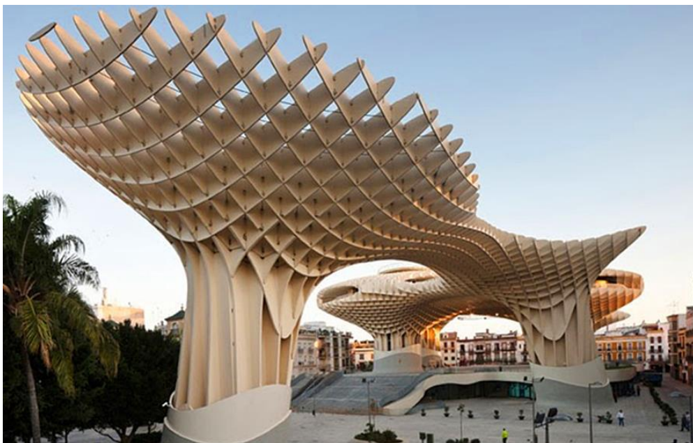
Imagem 43: Exemplo de estrutura waffle (Metropol Parasol por Jürgen Mayer H.).
