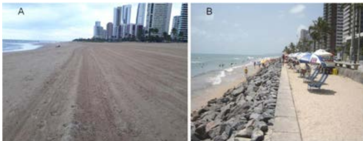
Figura 5 - Variação na largura do ambiente praiado emersa na praia de Boa Viagem: (A) extremo norte da área; (B) região mais ao sul, onde o processo de erosão exigiu a colocação de um enrocamento aderente.
