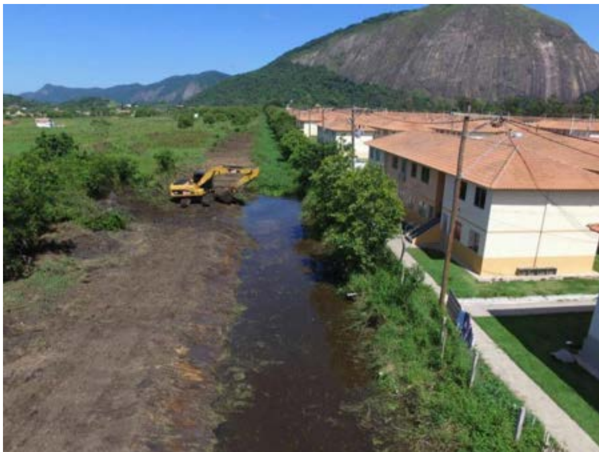
Figura 18 – Dragagem do Canal 1 – Estudo de caso 1 (EC-1) – Itaipuaçu – 4º Distrito de Maricá (RJ). Fonte: Maricá (2016).
