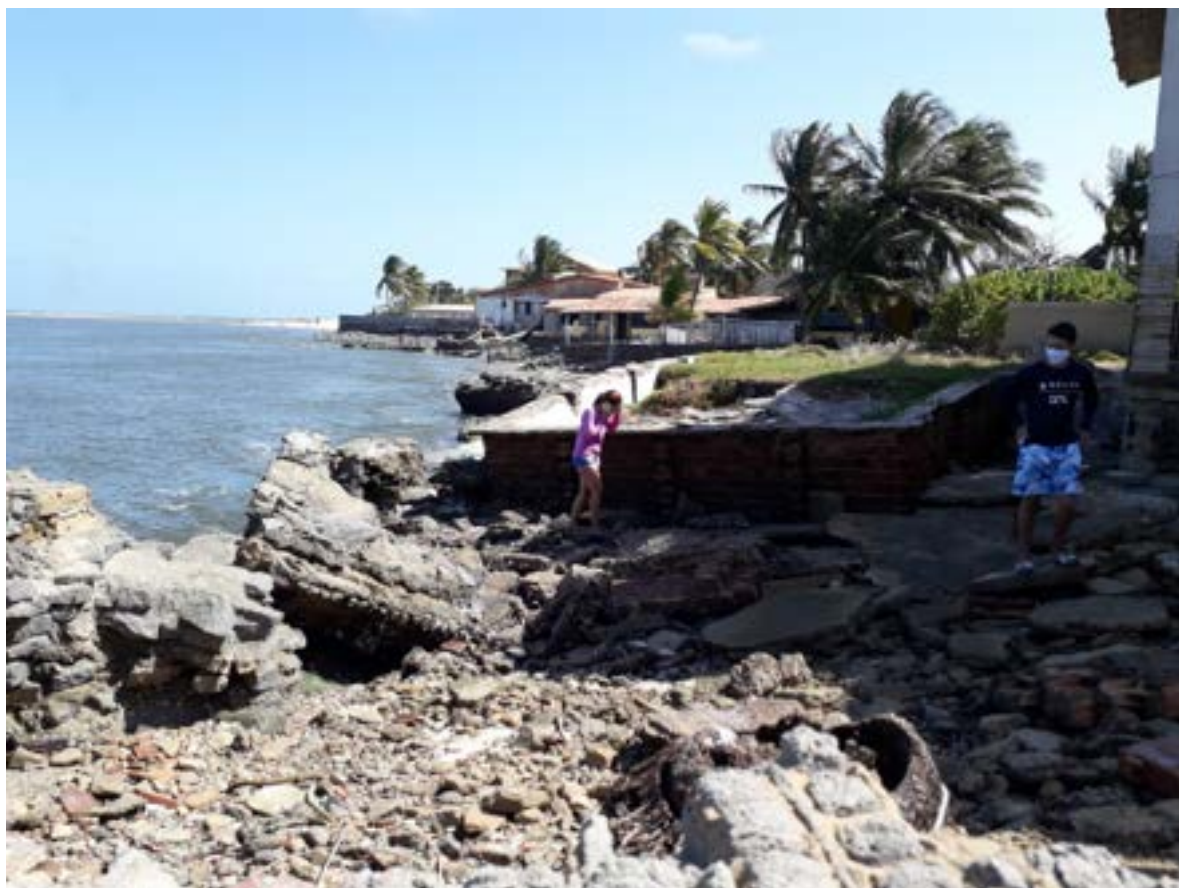
Figura 1 – Ação de processos erosivos marinhos e consequente destruição de edificações litorâneas, ao longo do litoral do bairro de Barra Nova (Município de Marechal Deodoro, Litoral Sul de Alagoas). Elaborado pelos autores.
