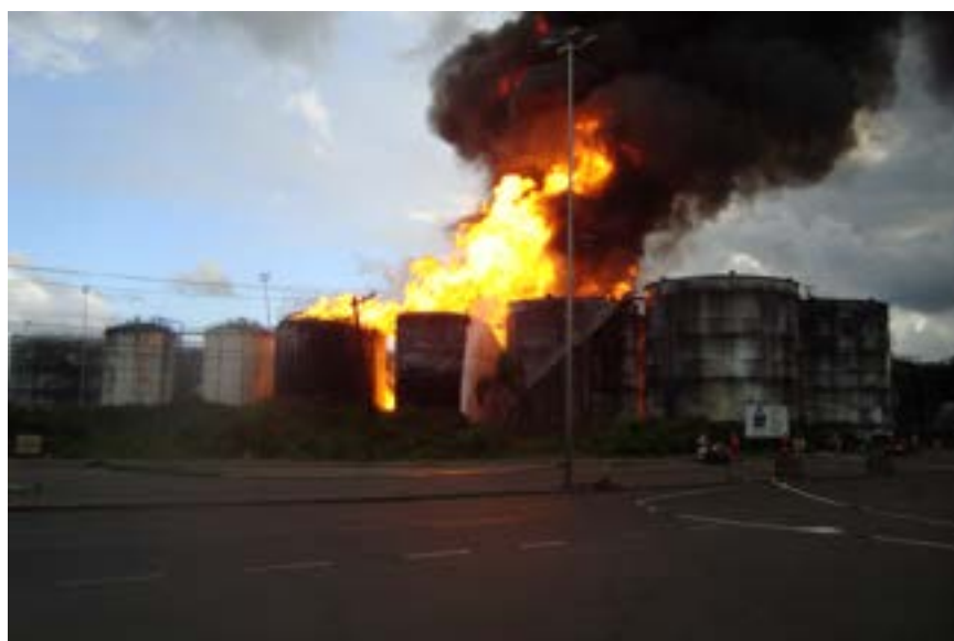
Figura 19 – Detalhe do incêndio em alguns tanques do Terminal . Fonte: CETESB (2016).
