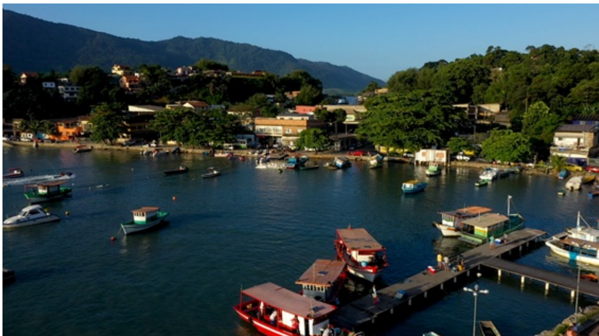
Figura 7 – Vista de parte do cais da Ilha da Madeira e bairro. Foto: Paulo Augusto Borghi Pla.
