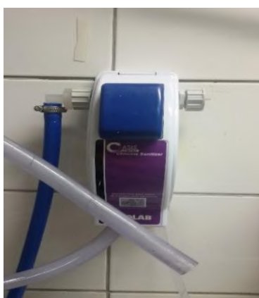
Figura 8 – Diluidor automático do Chlorine Sanitizer da marca ECOLAB
