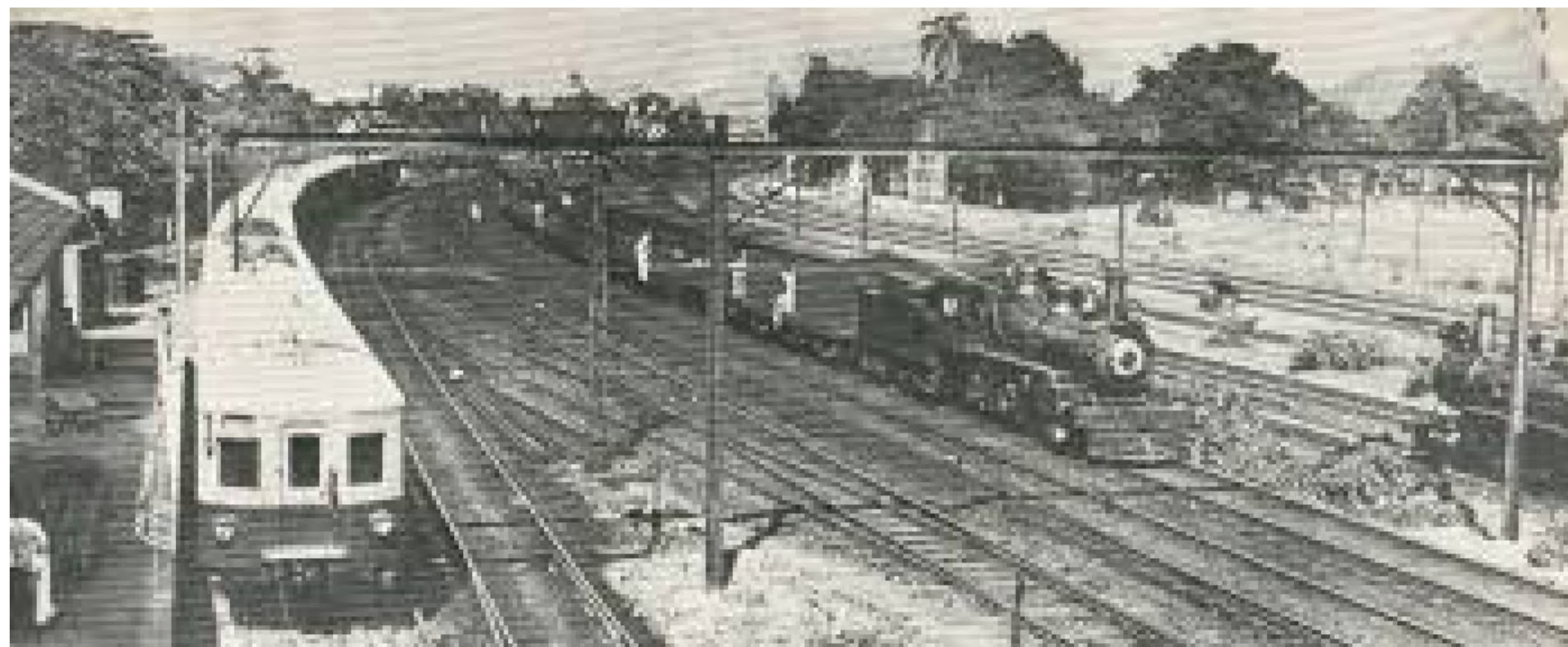
No bairro da Mangueira, trem eletrificado (esquerda) ao lado de um trem a vapor da Central (direita). Anos 1940 - Arquivo/FerreoClub
