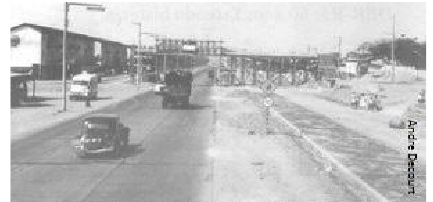
Canteiro de obras: a Avenida Brasil ainda era a "Variante"
