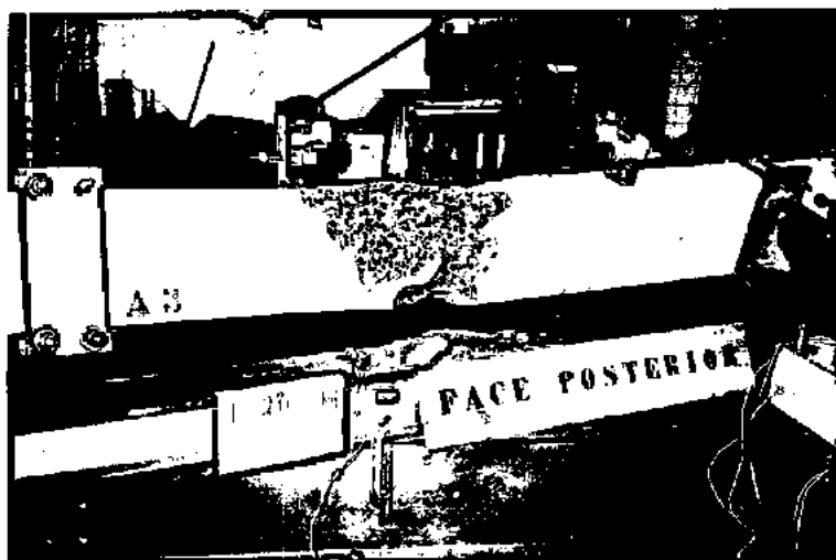
Foto 12 : Viga A-3 - face posterior
