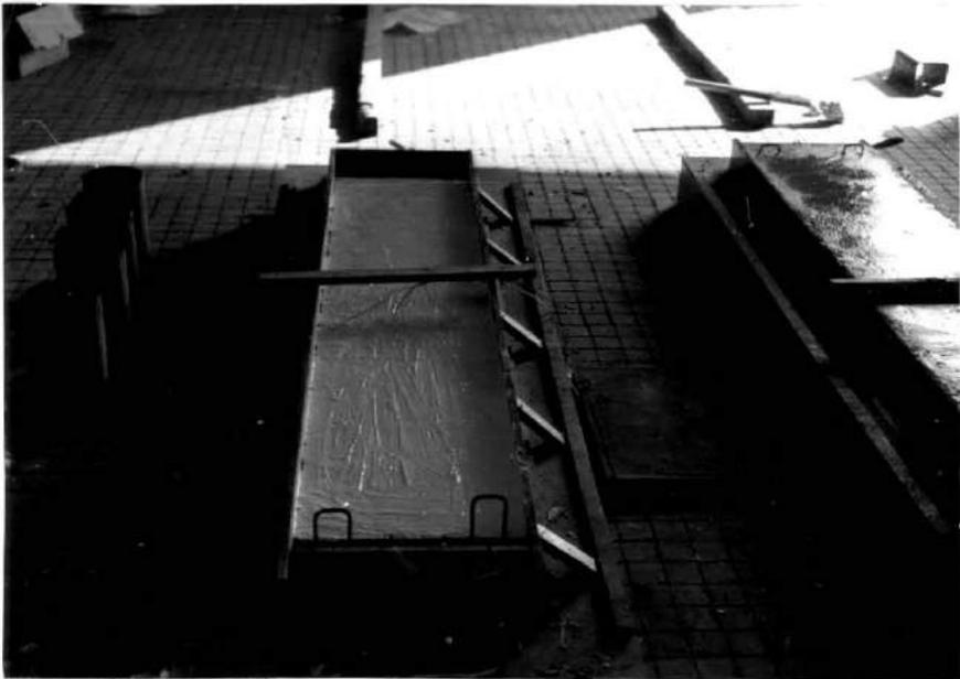
Fig. 21 - Adesivo estrutural no plano de ligação da laje pré-fabricada
