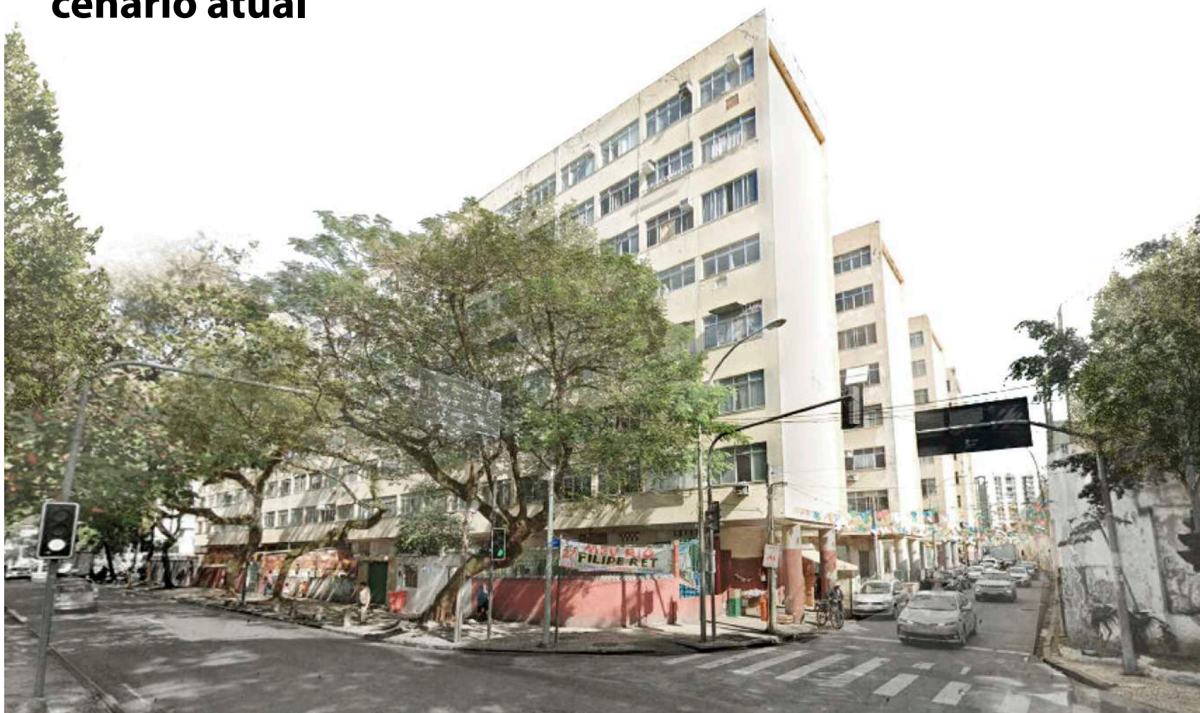
[53] vista da área de projeto - situação atual
