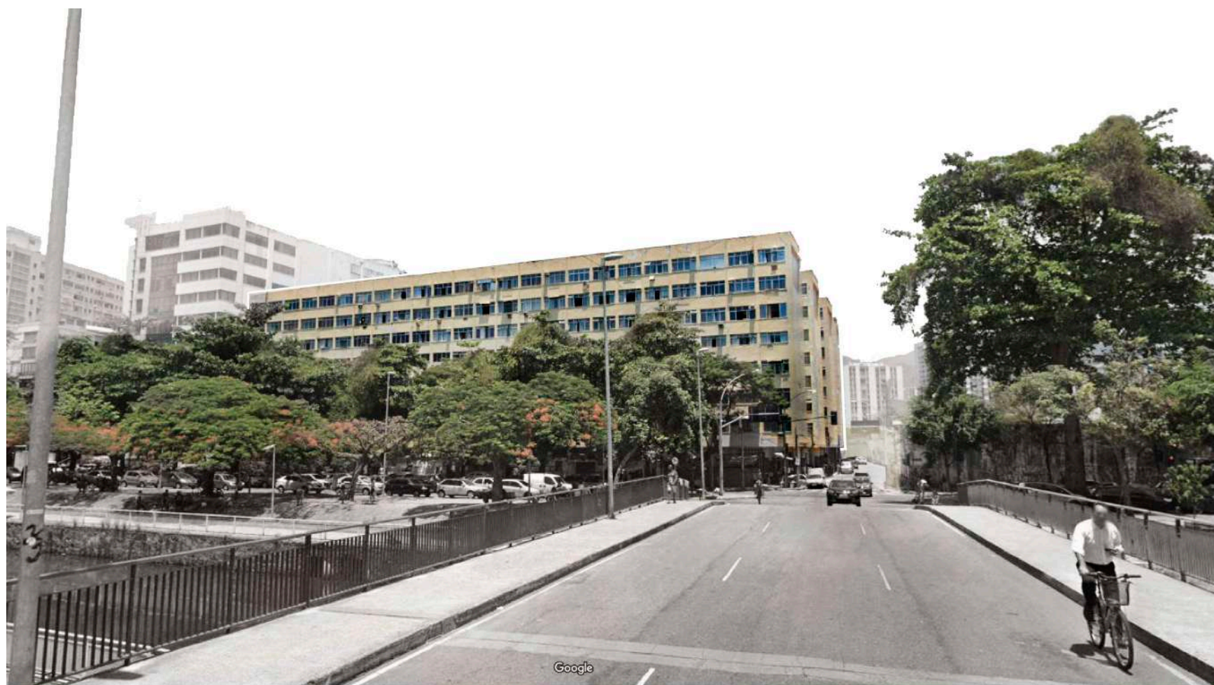
[51] vista da área de projeto - situação atual
