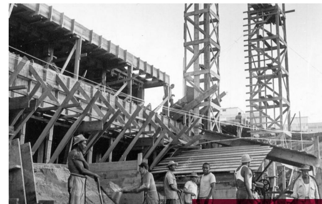
[7] Canteiro de obras - 09/12/1955
