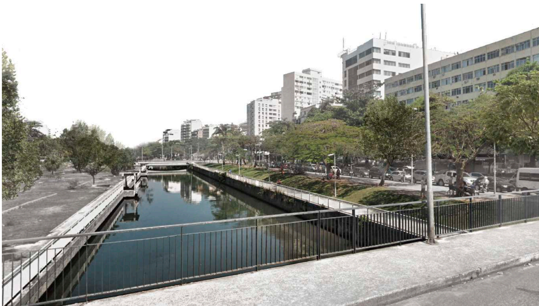
[57] vista da área de projeto - situação atual
