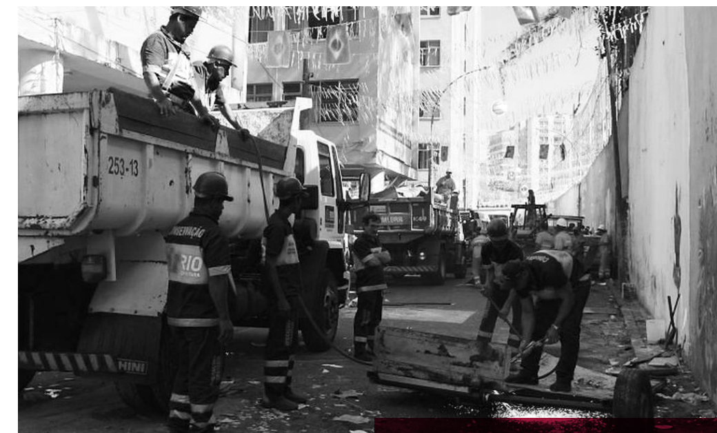
[14] Operação Choque de Ordem na Rua Humberto de Campos
