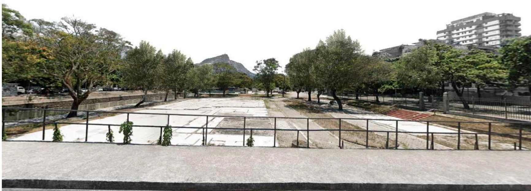
[59] vista da área de projeto - situação atual
