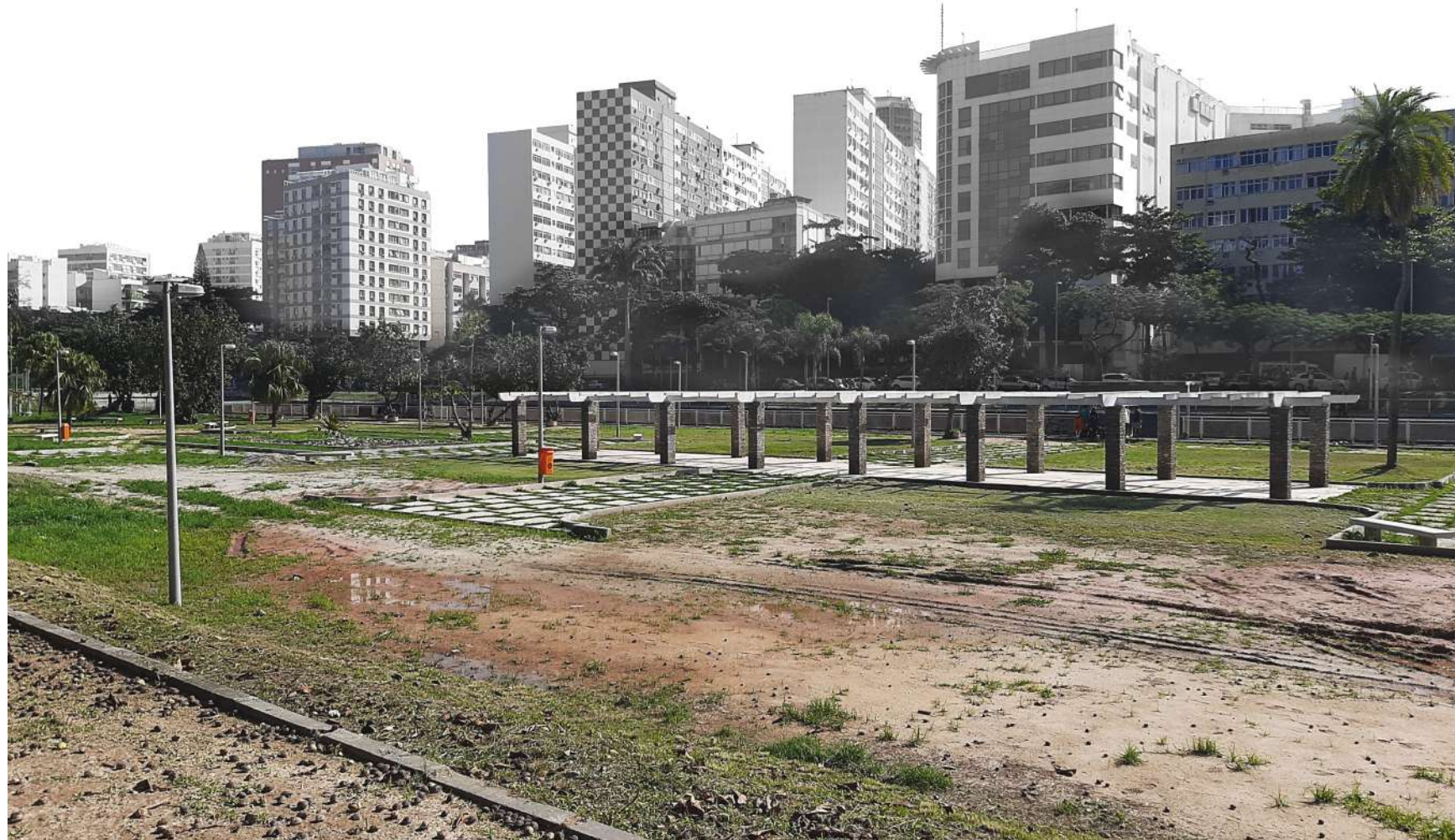
[61] vista da área de projeto - situação atual
