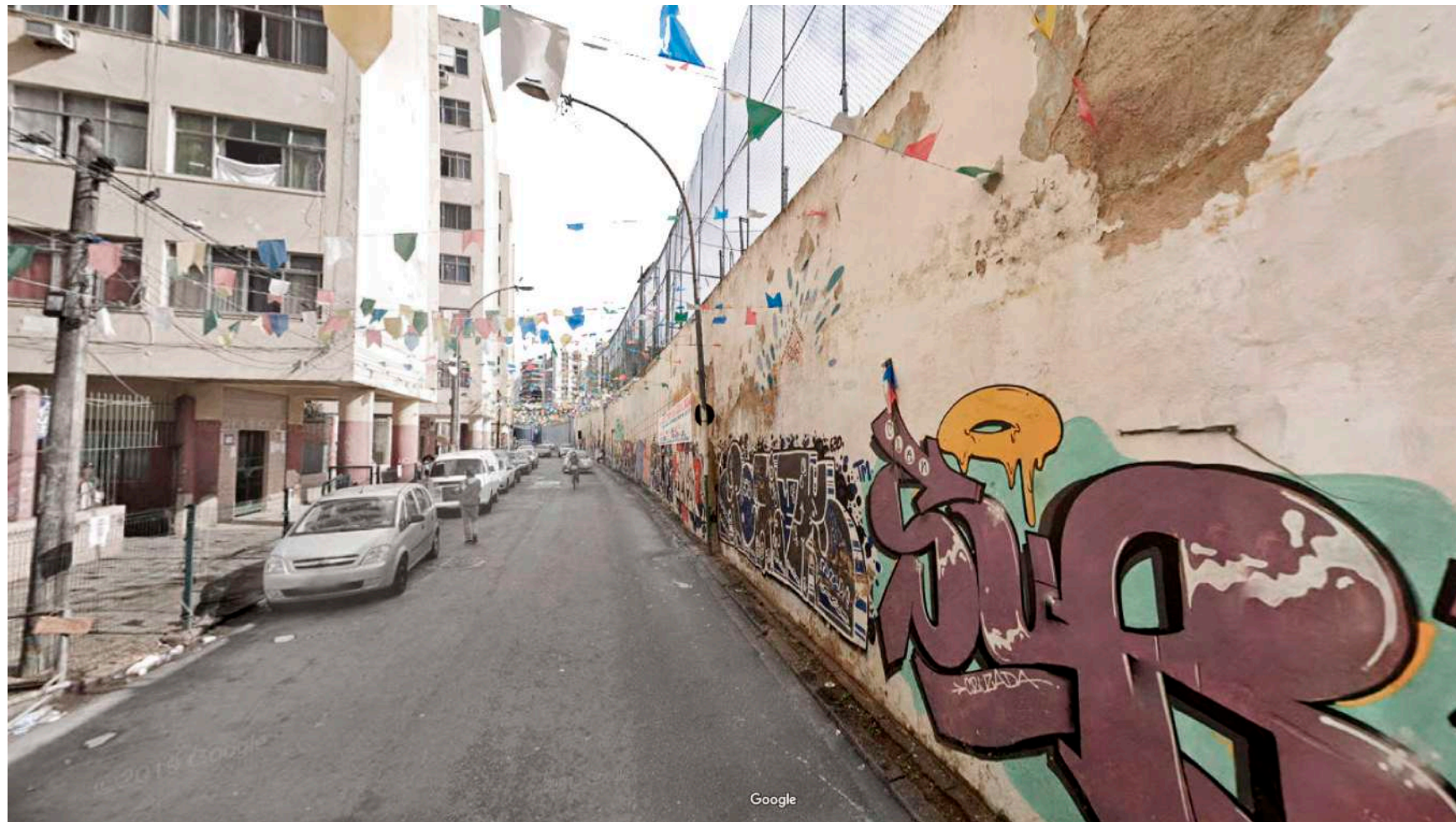
[49] vista da área de projeto - situação atual
