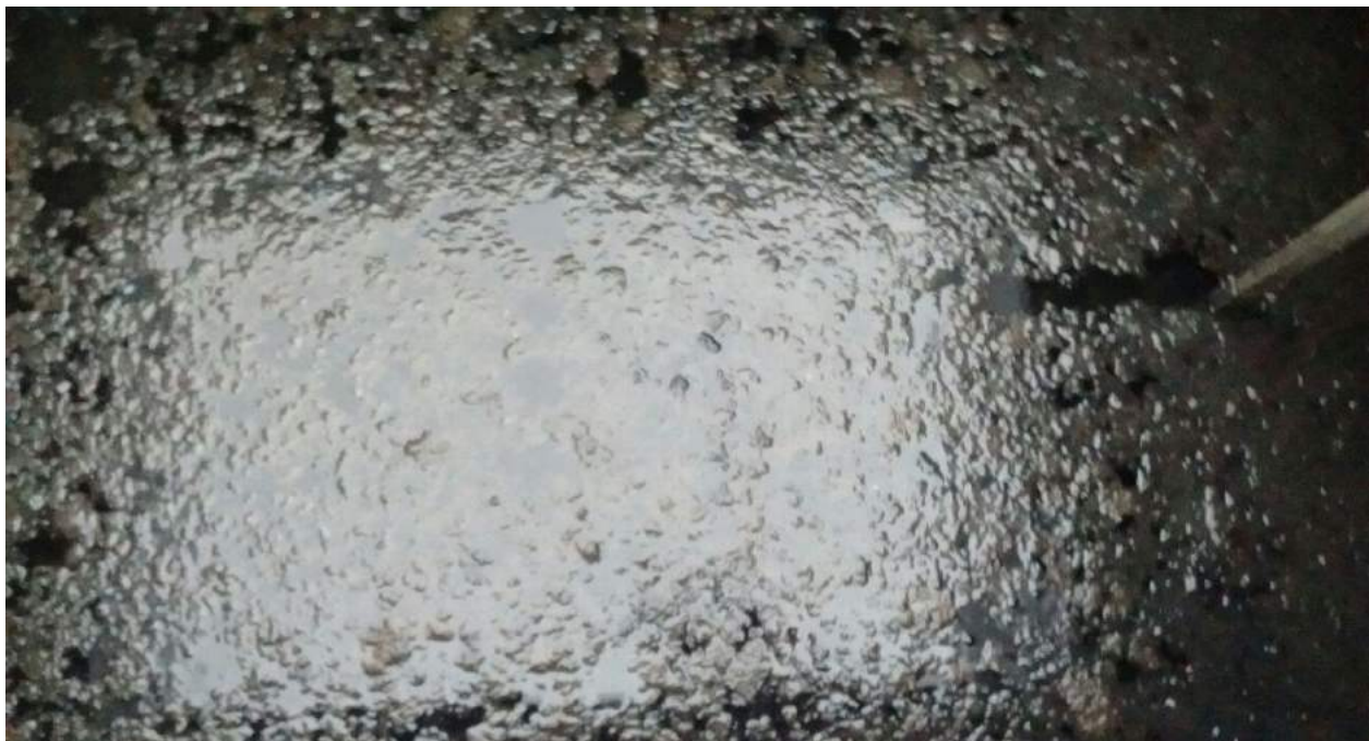
Figura 5.16: Decantador biológico com uma "manta" superficial de lodo: bulking do lodo (Fonte própria)
