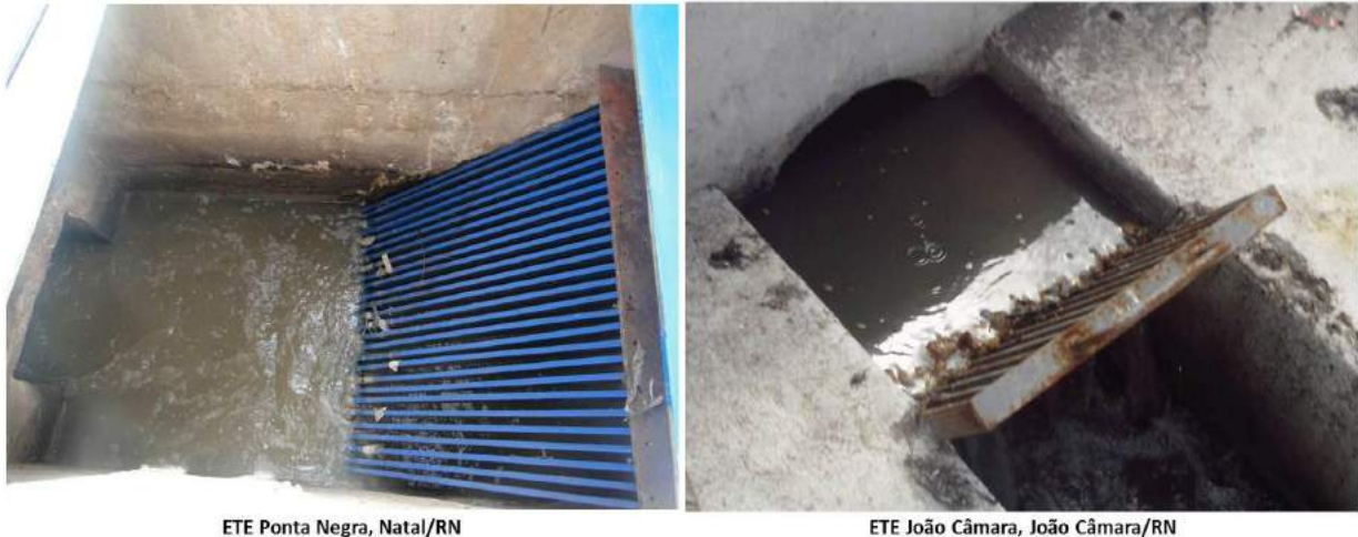
Figura 3.1 : Gradeamento da ETE Ponta Negra e de João Câmara no RN (Fonte: CAERN - Companhia de águas e esgotos do estado do Rio Grande do Norte, 2014)
