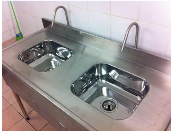
Figura 25: Pia hospitalar, feita em aço inoxidável ferrítico. Fonte: AFC Inox. Disponível em:
