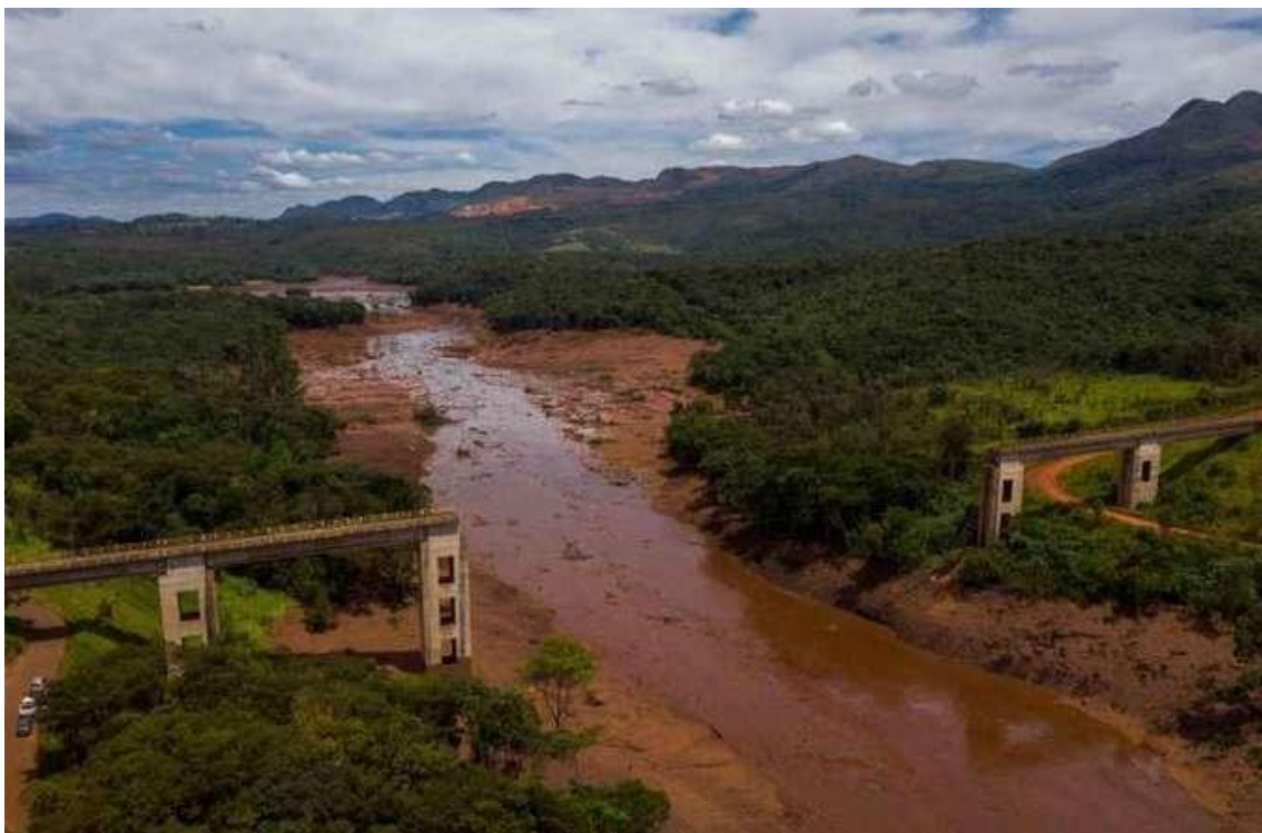
Figura 2: Rastro de destruição em Brumadinho
