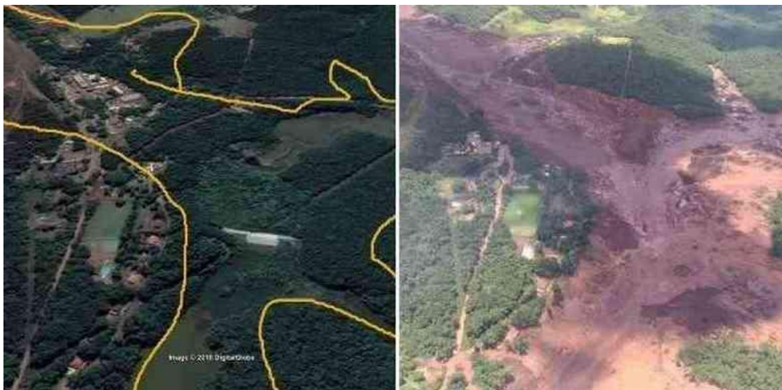
Figura 03: Imagens aéreas da região onde se rompeu a barragem Córrego do Feijão antes e depois da tragédia
